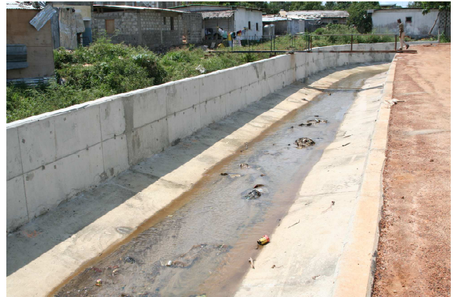
Canal d'évacuation des eaux pluviales en construction
