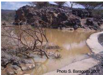
Digue en pierre maçonnée
