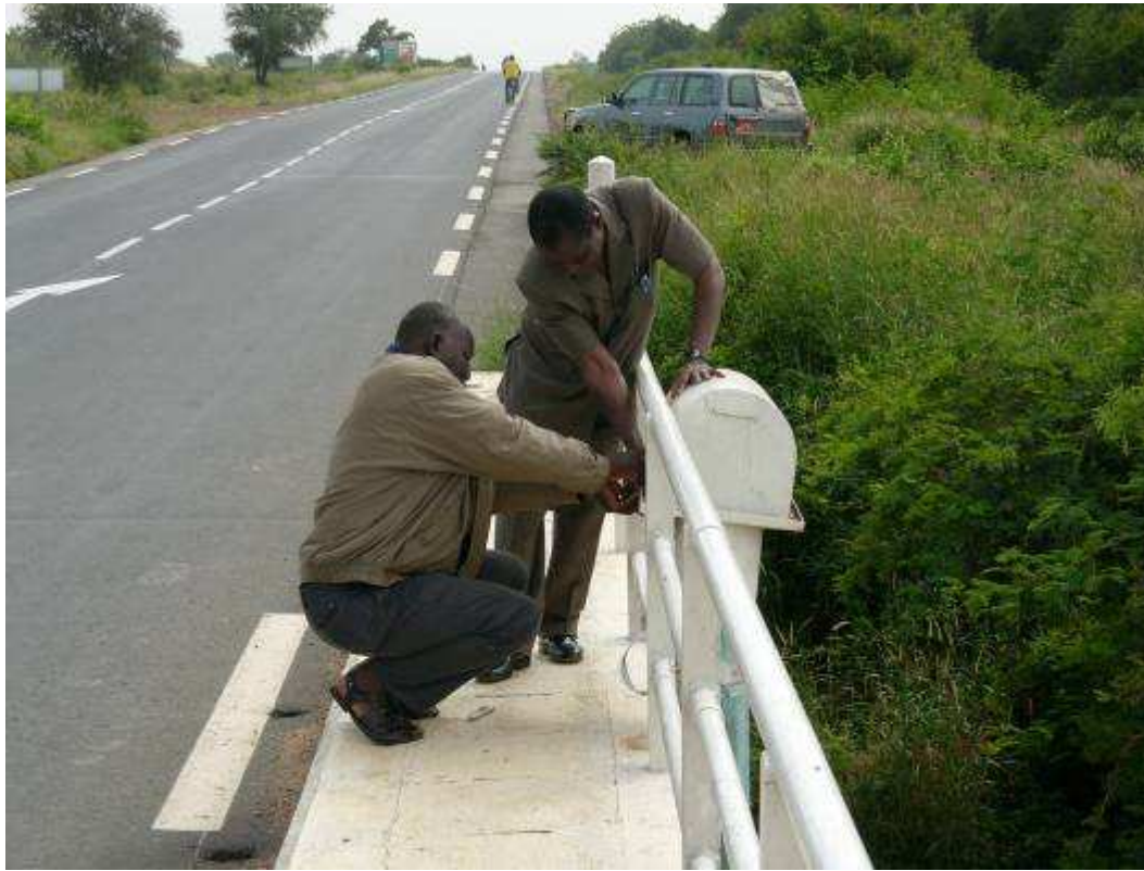
Photo 3 : Station Hydrométrique Rivier Nakambé à Gonse
