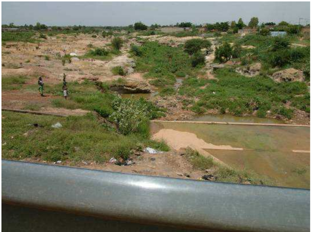
Photo 8: Le grand canal des eaux pluviales
