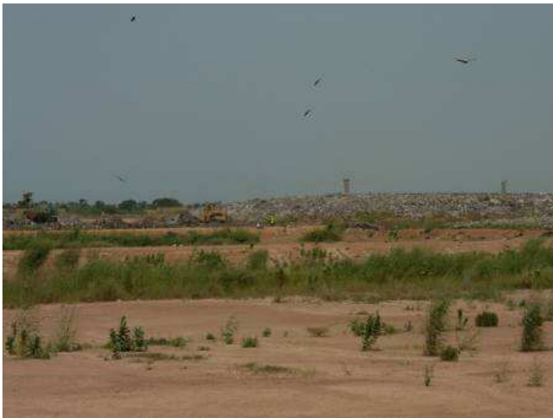
Photo 1: Polesgo Centre de Traitement et de Valorisation des Déchets
